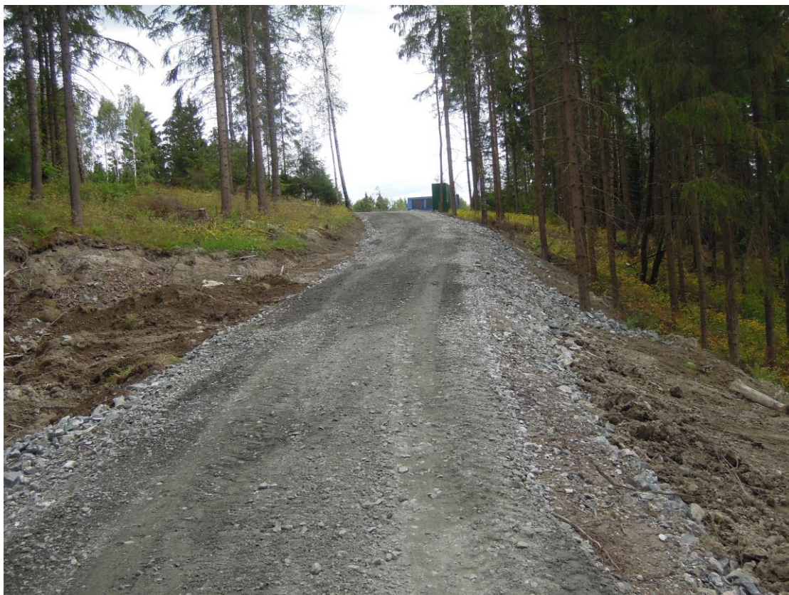
Figur 6.8. Vei fra parkeringsplass inn i planområdet. Foto: Leif Appelgren.
