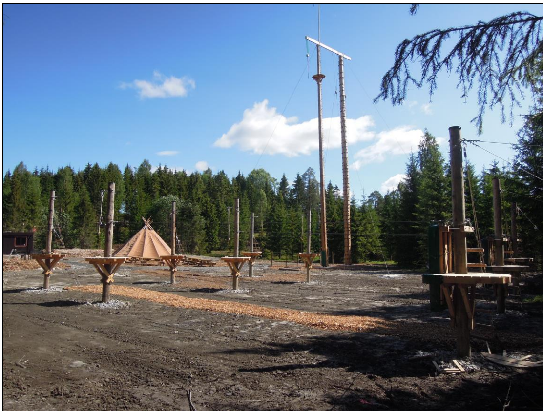
Figur 6.6. Stort anleggsområde nord i planområdet. Foto: Leif Appelgren.
